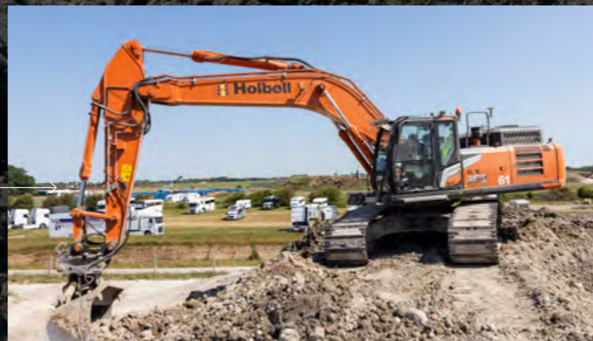
Maskinen har en arbejdsvægt på 36,3 tons og har kørt over 4.000 timer.
