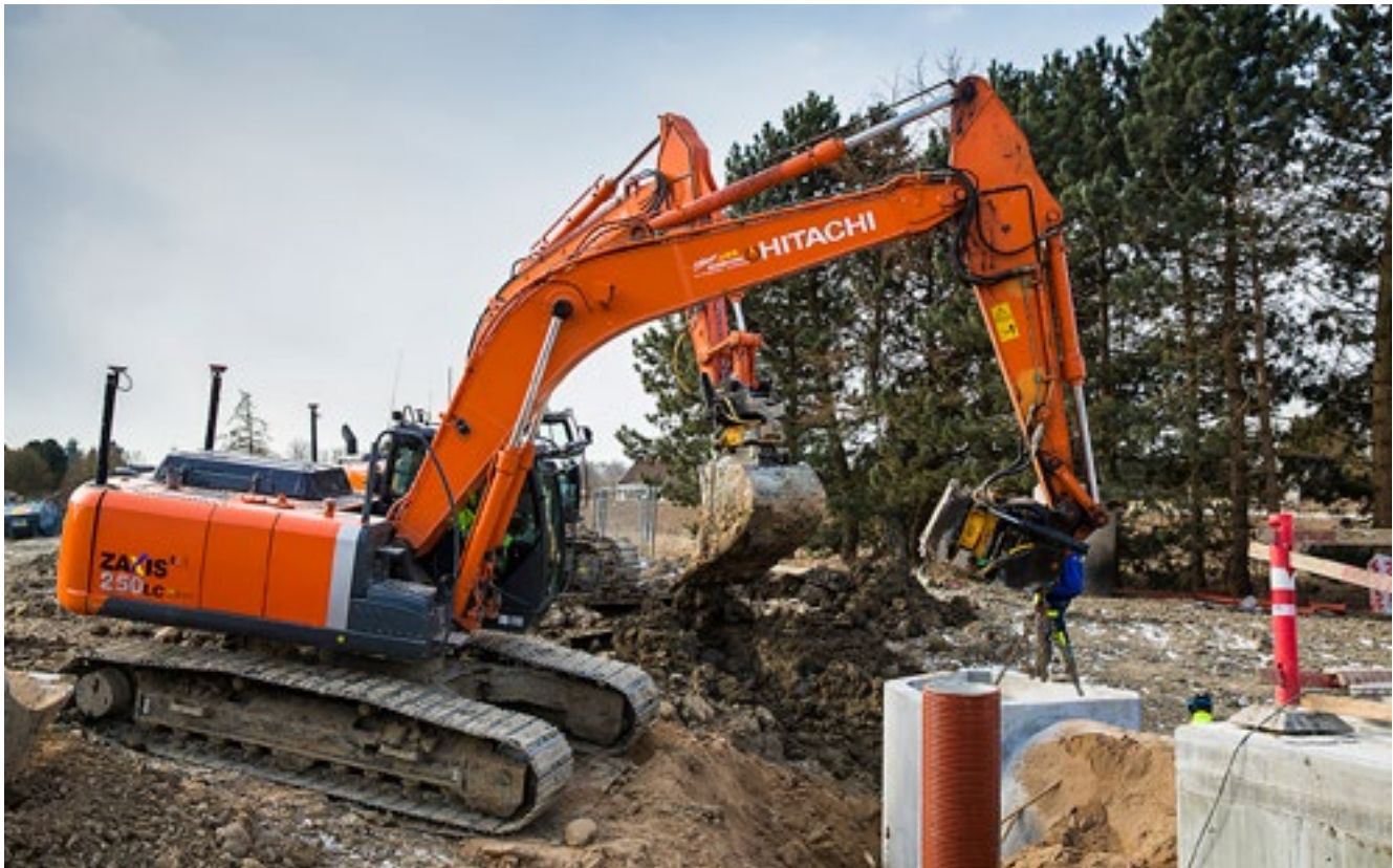
Entreprenørfirmaet Ollerup råder over 11 Hitachi gravemaskiner.
